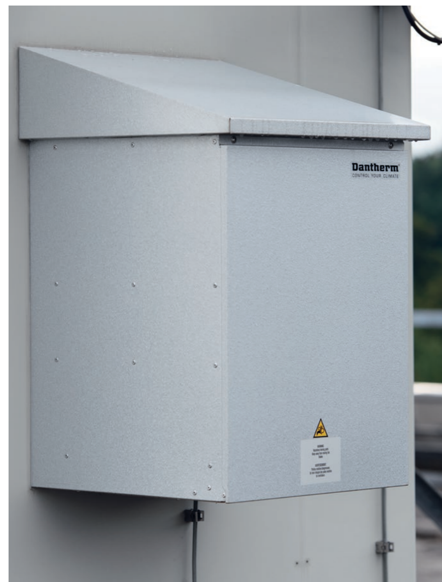
Die Flexibox der Firma Dantherm ist eine der neuen Lüftungsvarianten. Das Gerät wurde spezifisch für den Mobilfunk-Bereich entwickelt und hat eine Kühlleistung von 5,7 kW.
