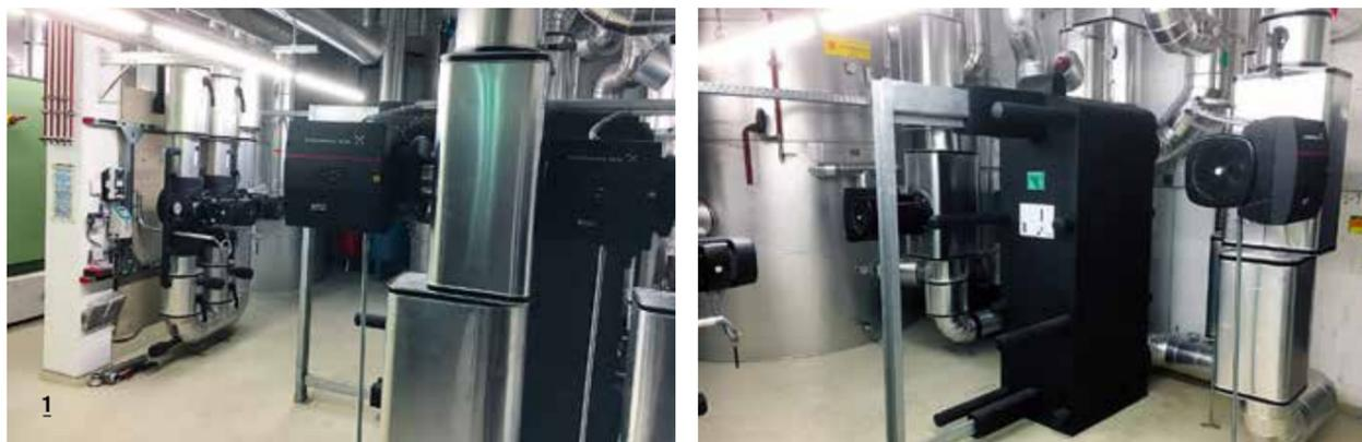
**1** Auch der neue Wärmetauscher arbeitet mit Strom aus der Photovoltaikanlage.
