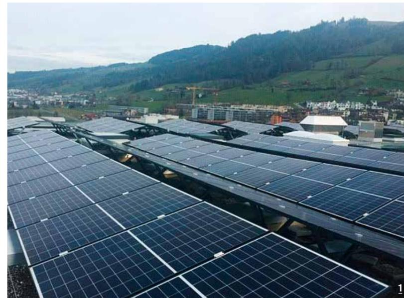
**1** Auf dem Neubau «Square One» wurde eine Photovoltaikanlage mit 750 Modulen installiert. Sie erzeugt eine Leistung von 250 kWp und dient dem Betrieb der Energiezentrale.
