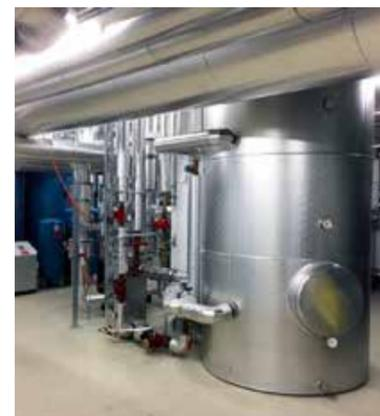
Der grosse Warmwasserspeicher in der neuen Energiezentrale geht über mehrere Geschosse.
