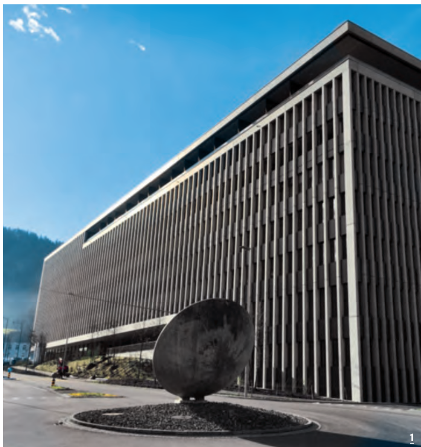
1 Le bâtiment neuf « Square One ».
