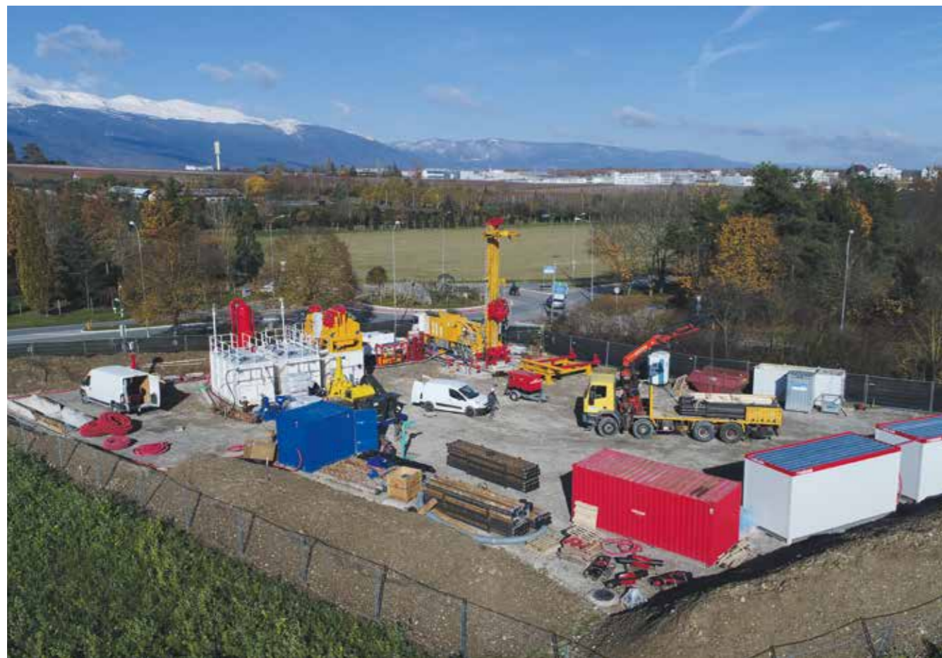
4 Explorationsbohrungen für die Nutzung von Geothermie im Kanton Genf.
