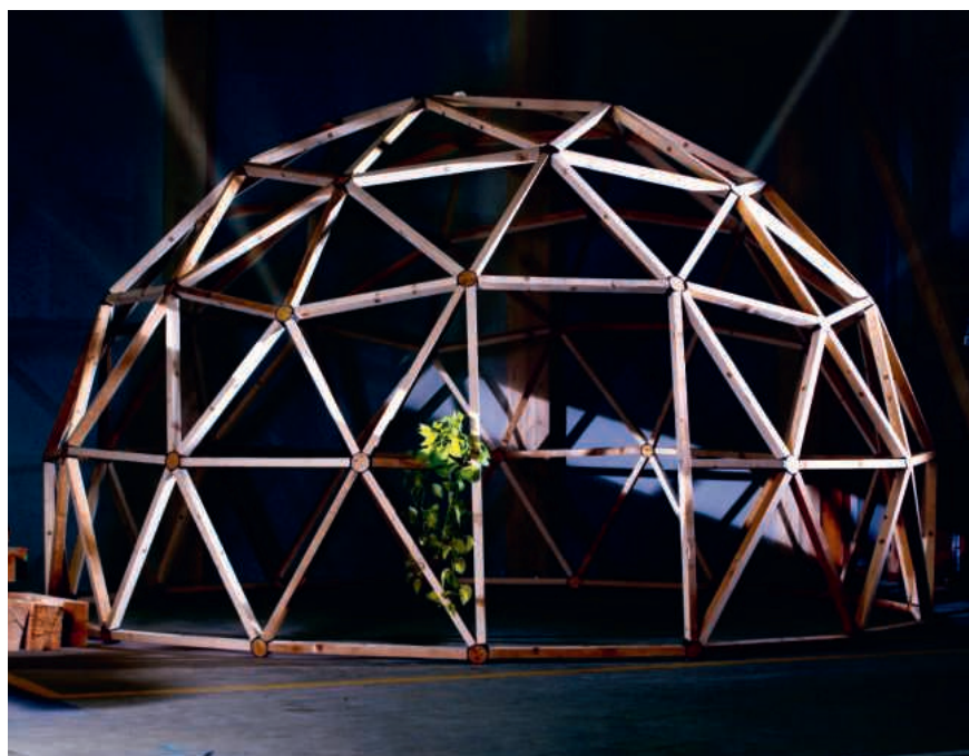
Digitale Methoden und Muskelkraft machen aus Bauabfällen eine Holzkuppel.
