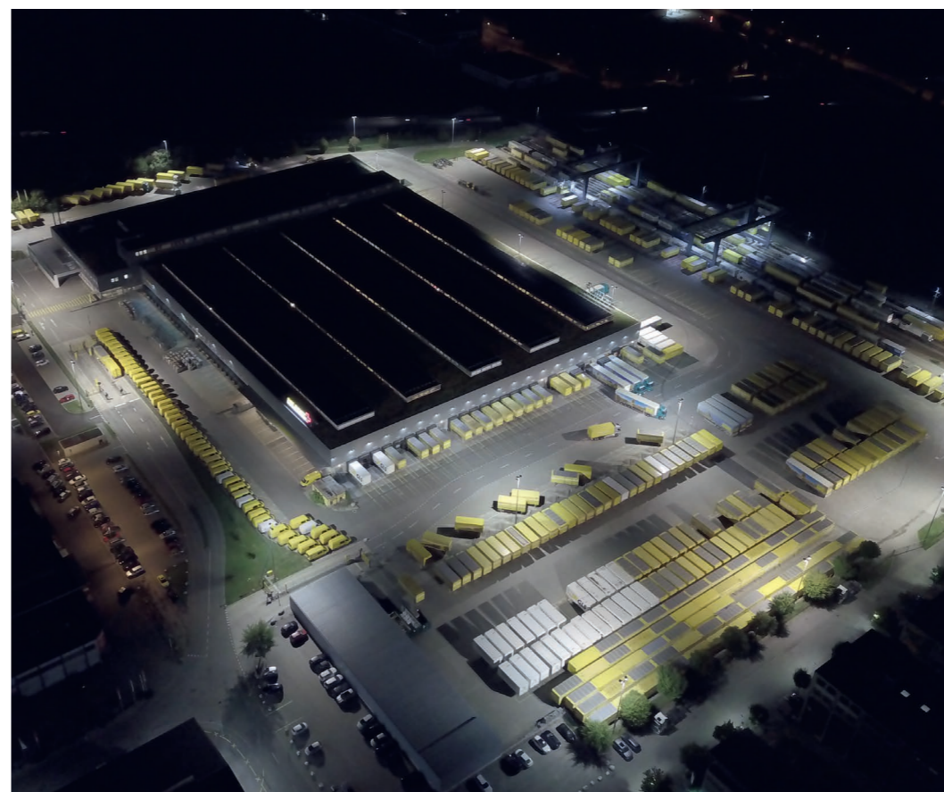
Le centre colis de Frauenfeld est en service depuis 1998 et traite 300 000 colis par jour. Les quelque 70 000 m 2 doivent rester éclairés presque toute la nuit.
