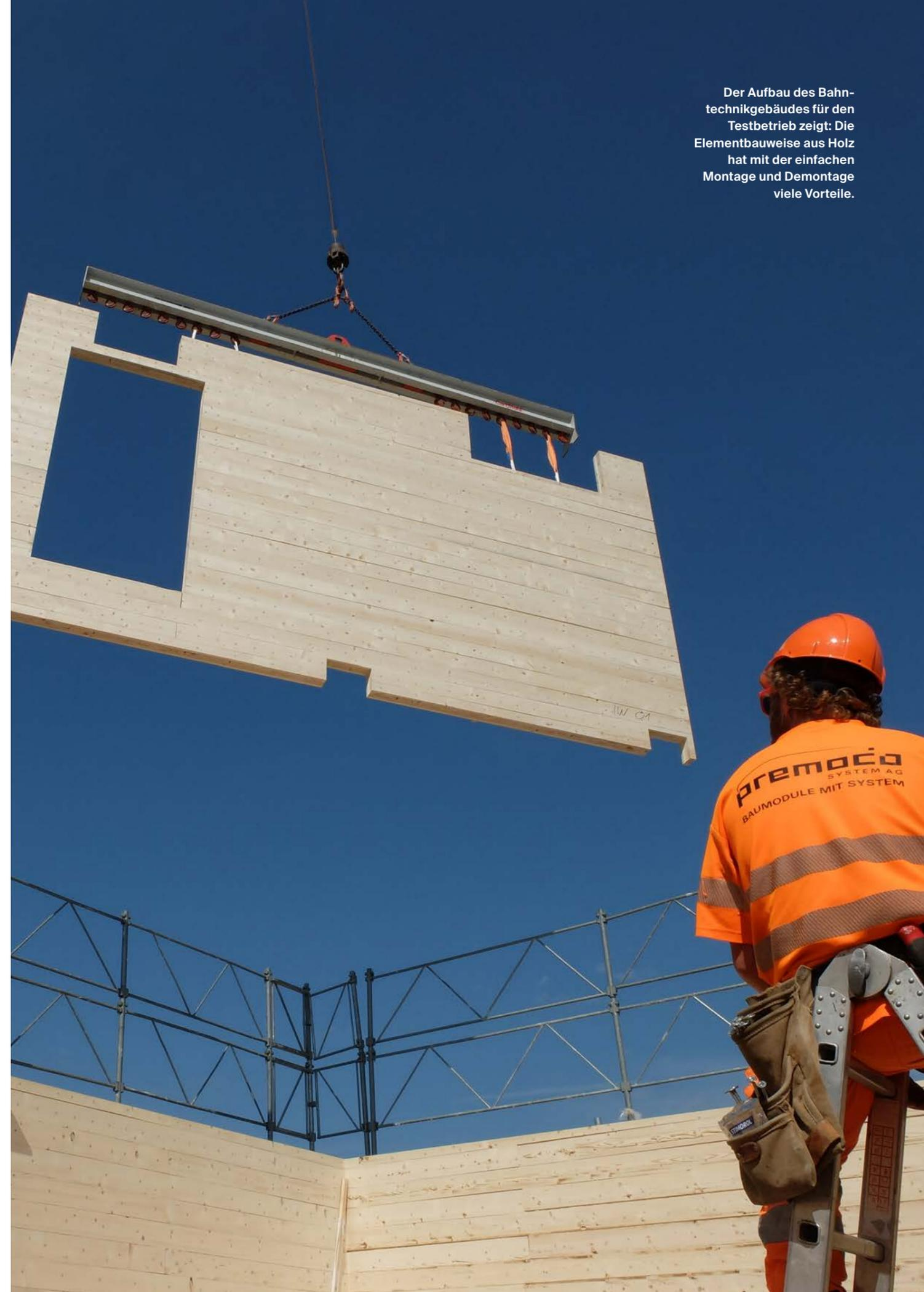
Der Aufbau des Bahntechnikgebäudes für den Testbetrieb zeigt: Die Elementbauweise aus Holz hat mit der einfachen Montage und Demontage viele Vorteile.
