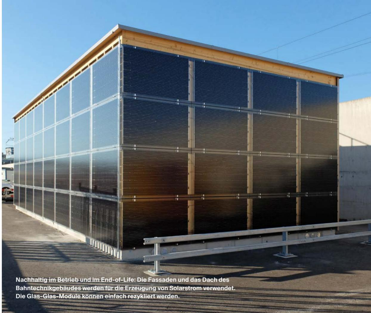
Nachhaltig im Betrieb und im End-of-Life: Die Fassaden und das Dach des Bahntechnikgebäudes werden für die Erzeugung von Solarstrom verwendet. Die Glas-Glas-Module können einfach recycelt werden.
