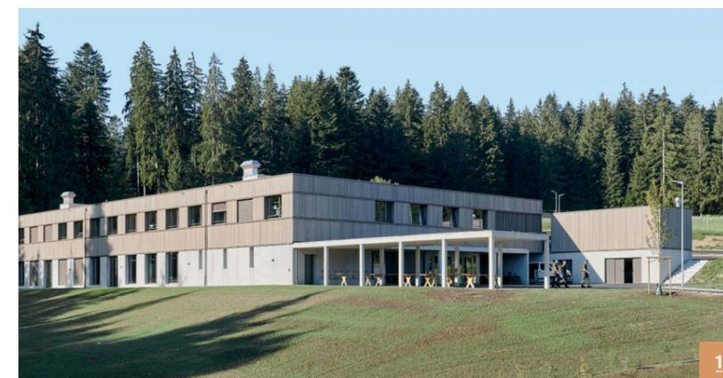
1 Le bâtiment à construction modulaire bois et béton se trouve sur une légère pente et s'intègre harmonieusement dans l'environnement. La façade a été entièrement réalisée en bois suisse.
