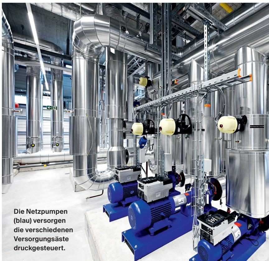
Die Netzpumpen (blau) versorgen die verschiedenen Versorgungsäste druckgesteuert.
