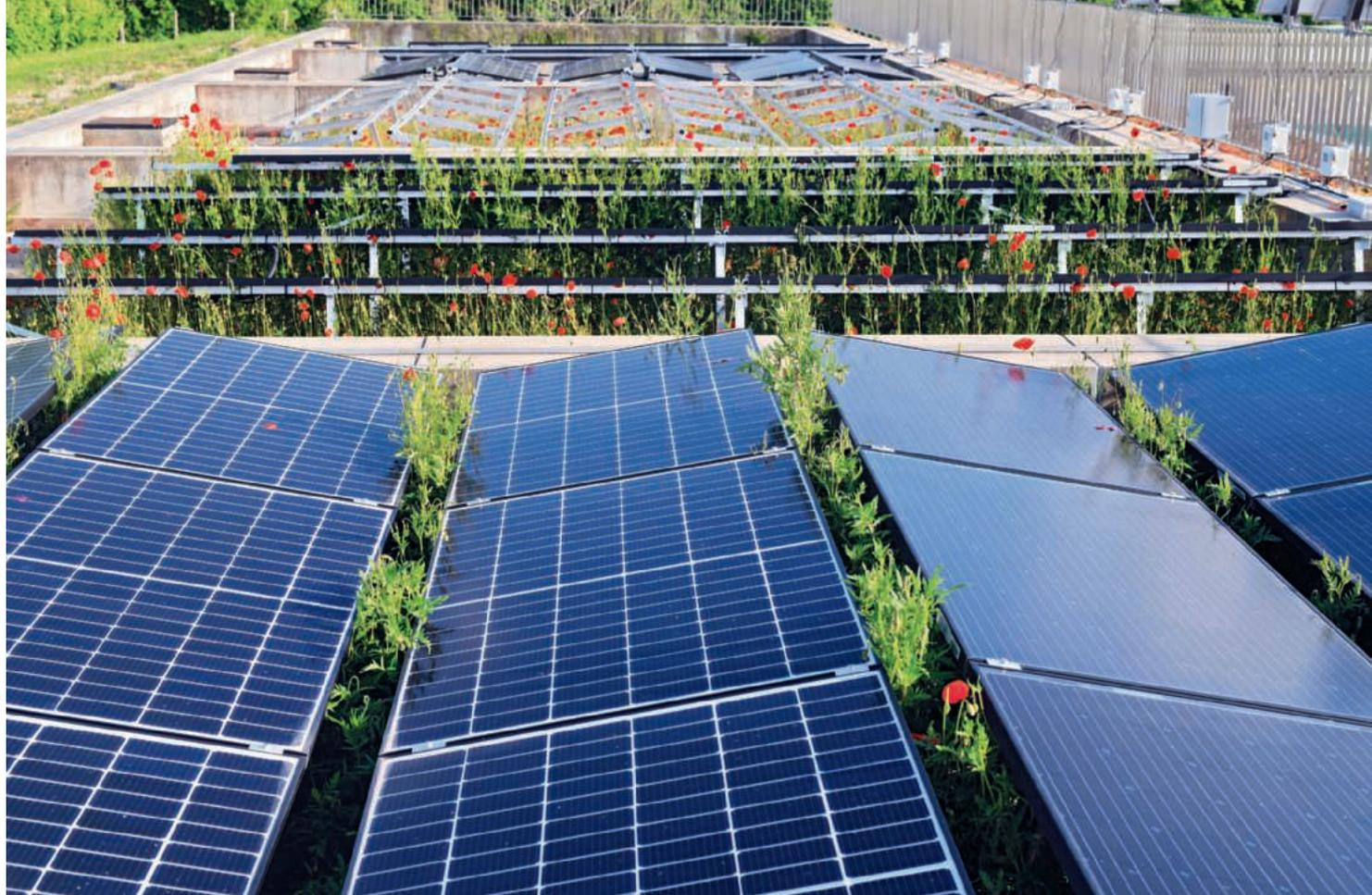
**Ein von SIG finanziertes Projekt der HEPIA testet die Kombination von Photovoltaikmodulen und Dachbegrünung.**
