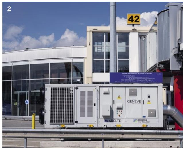
**3** Les pompes à chaleur air-air sont installées respectivement au pied des passerelles d'embarquement, à partir desquelles le tuyau est acheminé jusqu'aux avions.
