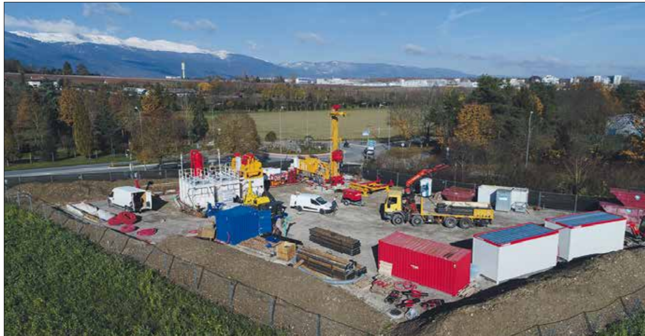
Forages d'exploration pour l'exploitation de la géothermie dans le canton de Genève. SOURCE: SIG
