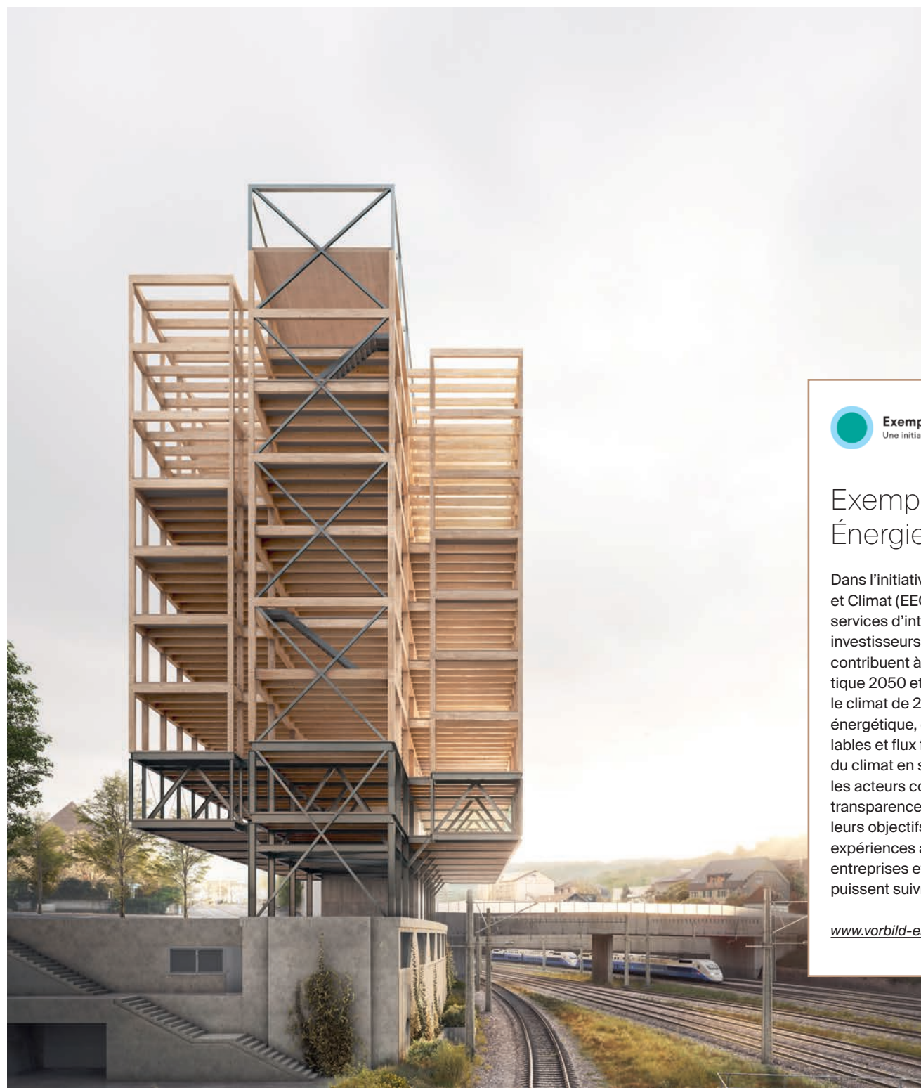
Structure porteuse des étages standards constituée d'une construction en bois préfabriquée.
