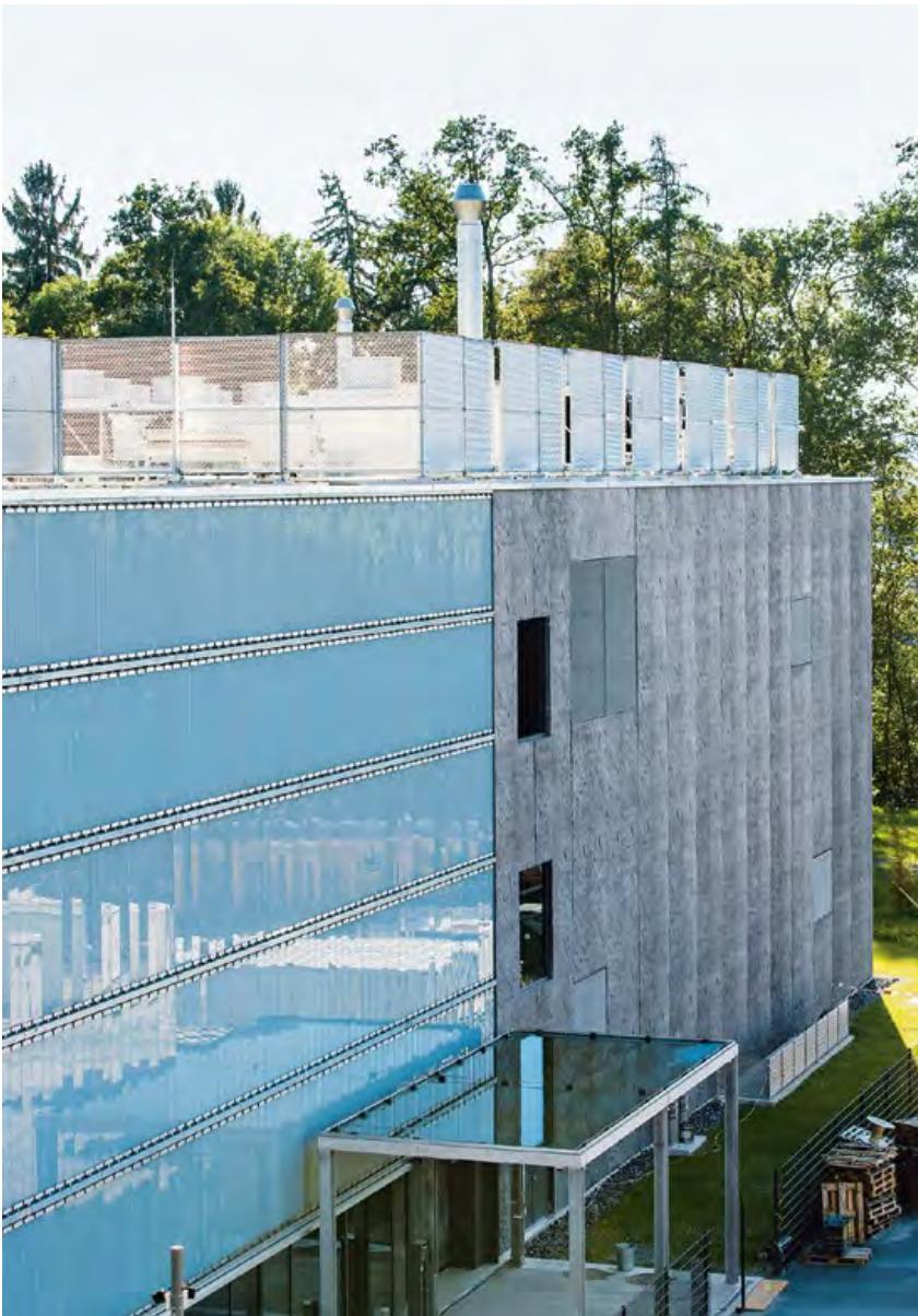
Il nuovo centro di calcolo di Berna Wankdorf
