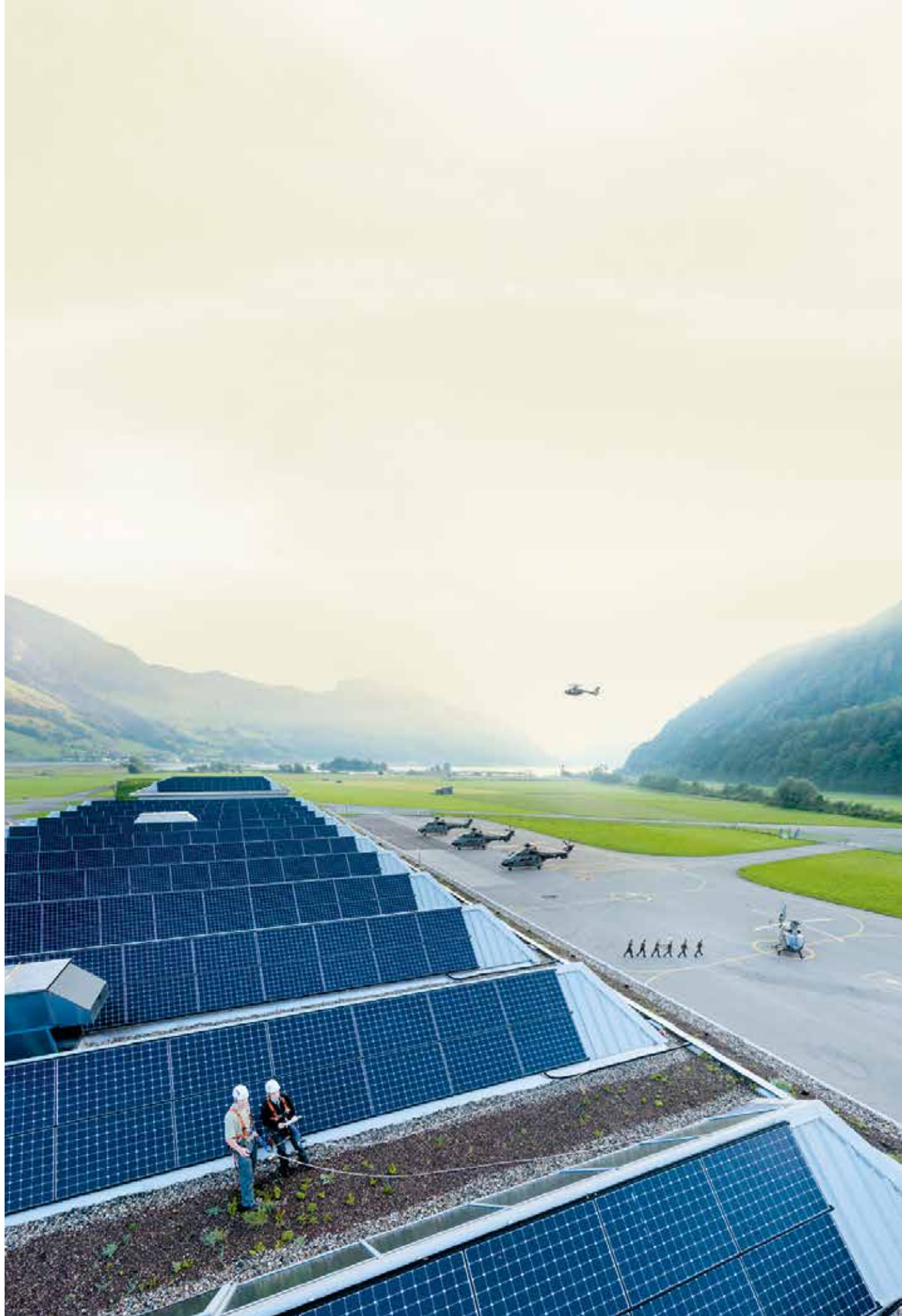
Impianto fotovoltaico all'aerodromo militare di Alpnach.
