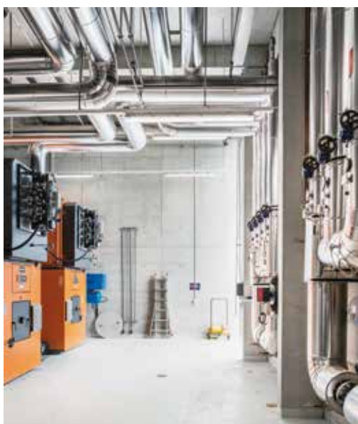
Presso l'aeroporto militare di Payerne il DDPS ha sostituito il riscaldamento fossile mediante una centrale con riscaldamento a cippato e pompa di calore.
