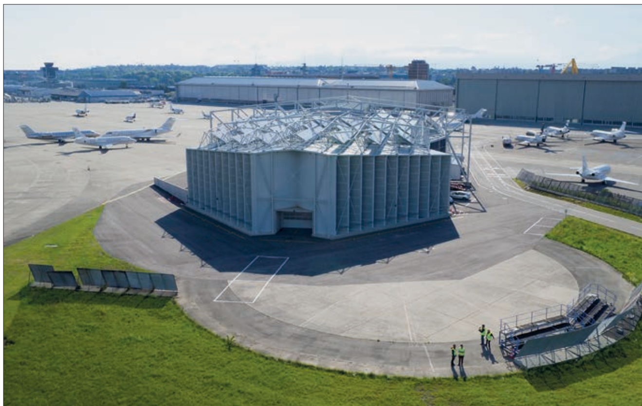
Les panneaux phono-absorbants sur les murs du bâtiment amortisseur de bruit se composent de milliers de petites percées remplies de laine de verre qui réduisent d'une vingtaine de décibels le bruit émis vers l'extérieur. 909 panneaux photovoltaïques produisent 200 MWh/an.
