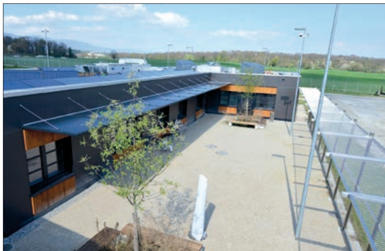
Spécificités du bâtiment INAD labellisé Minergie-P: dalles en béton armé, murs porteurs en parpaing plein, PAC couplée à 5 sondes géothermiques (longueur totale 1180 m) pour le chauffage et un rafraîchissement par géo-cooling. Capteurs solaires thermiques production 7 MWh/an et panneaux photovoltaïques 14 MWh/an.
