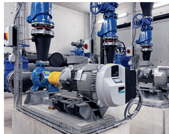
Blick auf die Pumpen der Seewasserfassung der BLS-Werkstätte.
