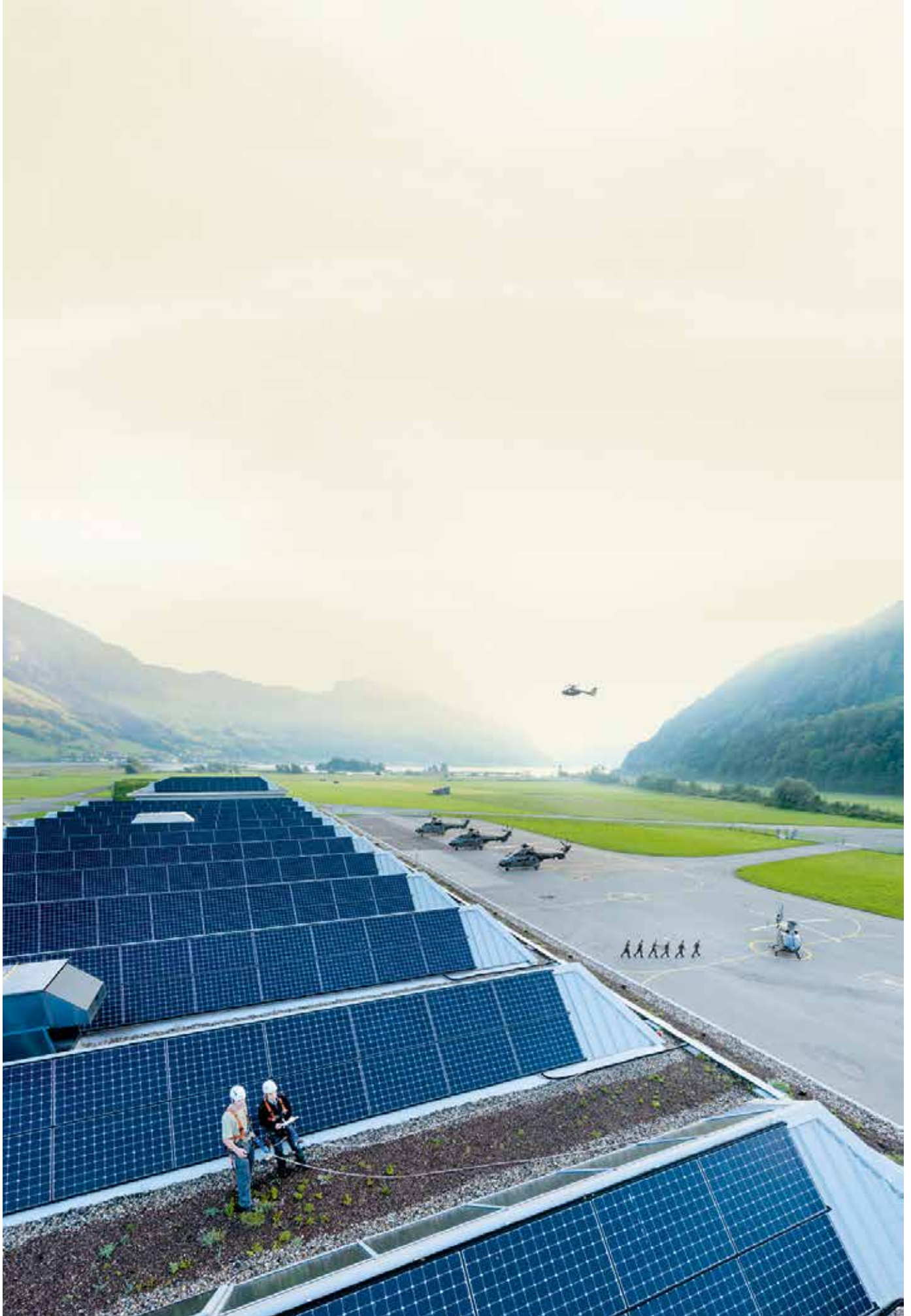
Photovoltaikanlage auf dem Militärflugplatz Alpach.
