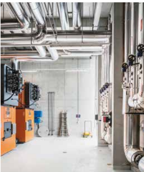
Auf dem Militärflugplatz Payerne hat das VBS eine fossile Heizung durch eine Heizzentrale mit Holzsnitzelheizung und Wärmepumpe ersetzt.
