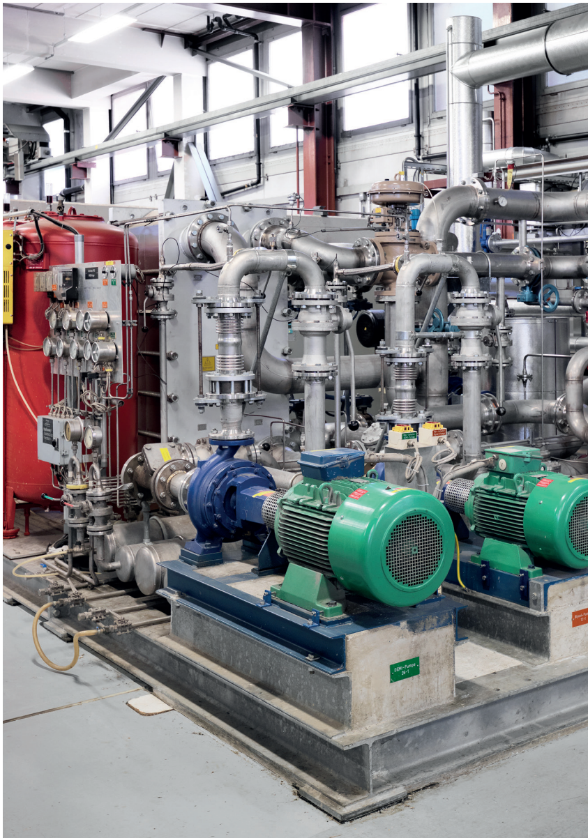
Teil des Kühlkreislaufes, der heute auch als Abwärmequelle dient
