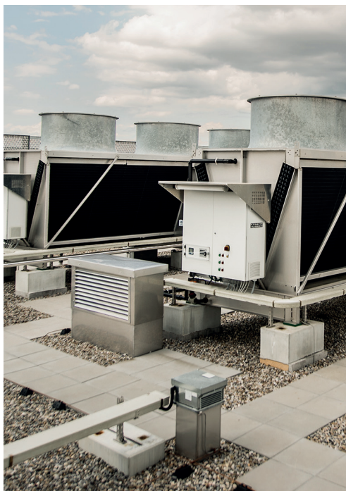
Hybride Rückkühler auf dem Dach des RZ Wankdorf
